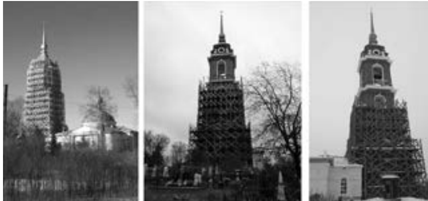
Этапы восстановления колокольни церкви Богоявления Господня: 2015–2017 годы
