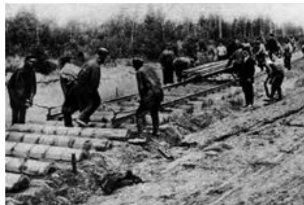
■ На строительстве железной дороги под Рыбинском
