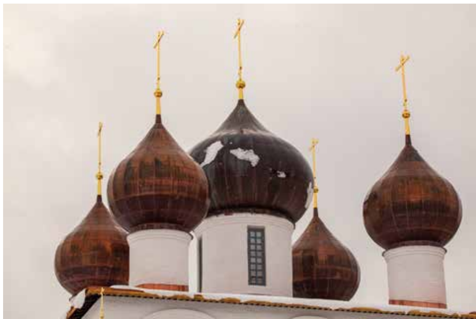
Восстановленные купола и кровля Богоявленского храма
