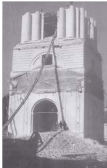
• Разборка колокольни Крестовоздвиженского прихода. Фото 1930 года
